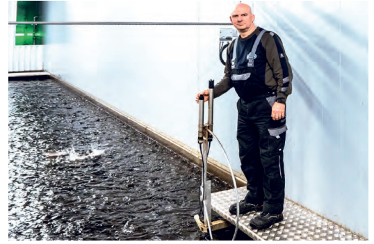
FREA-Fischereimeister Egon Folmer zeigt einen der speziellen Drehbügel, an dem ein digitaler pH-Sensor des Typs SensoLyt® 700 IQ und der optische, kalibrierungsfreie Sauerstoffsensor FDO® 700 IQ montiert sind.
